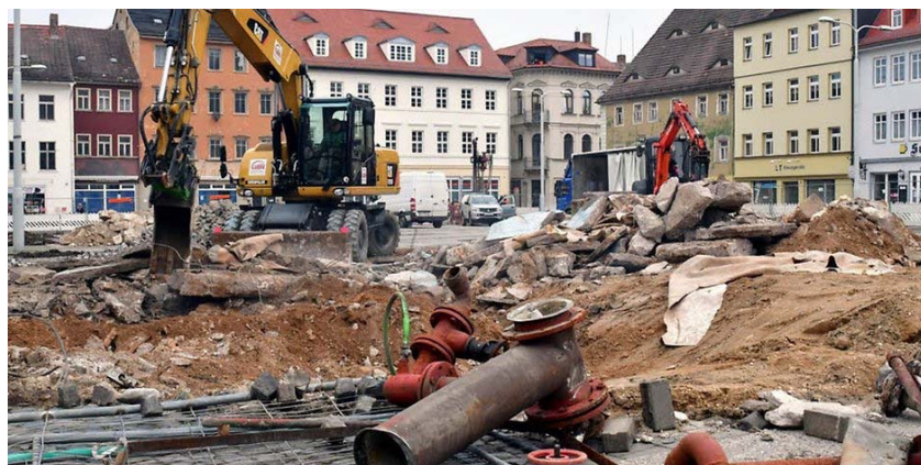
Baustelle auf dem Weißenfelser Marktplatz. Foto: Peter Lisker
