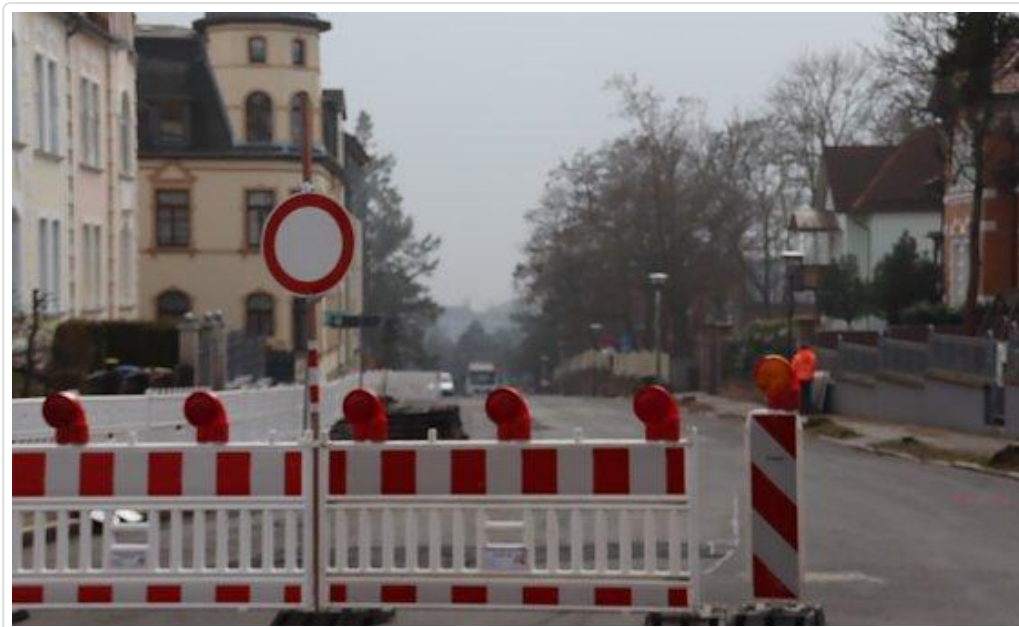
Die Arbeit zur Sanierung der Riemannstraße beginnen (Foto: Stadtverwaltung Nordhausen)
