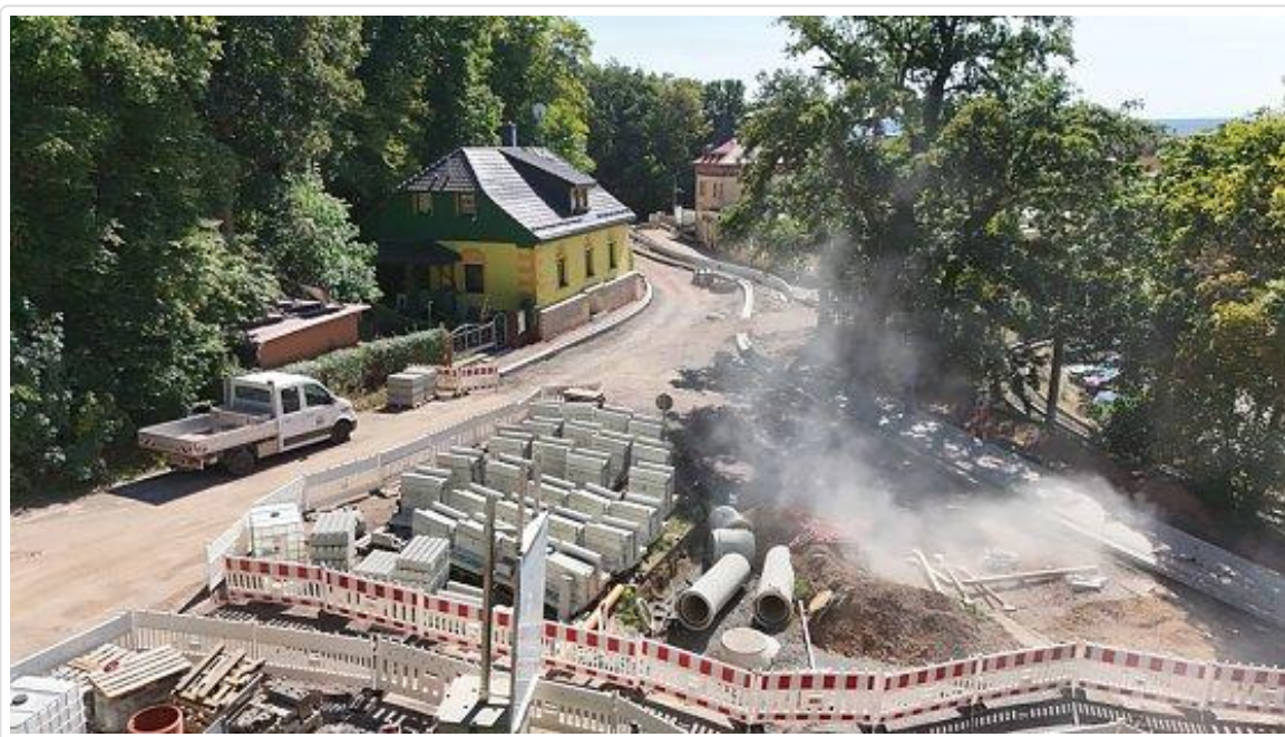
Baustelle aus der Luft (Foto: Stadtverwaltung Nordhausen)
